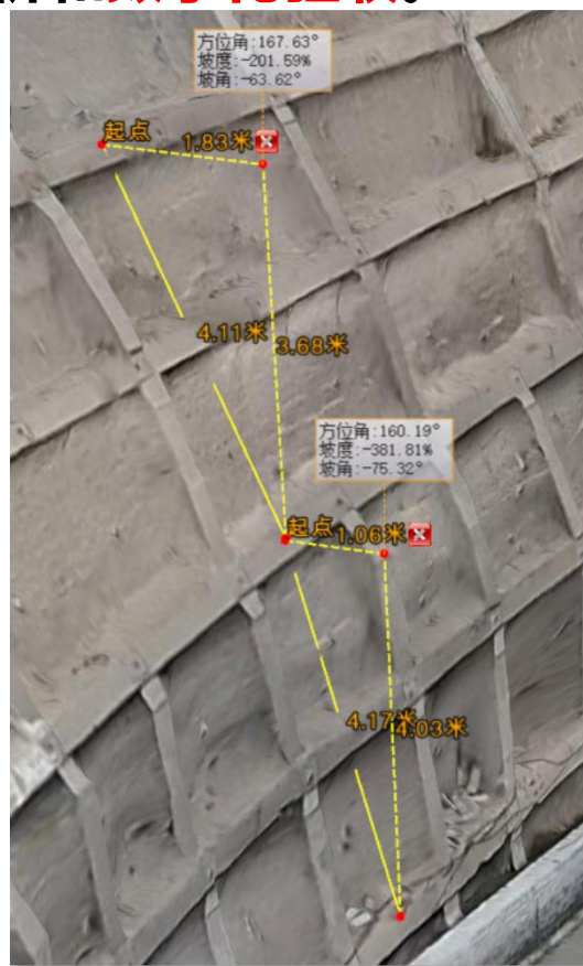
边坡角度实景测量
